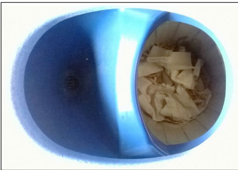
Trenntoiletteneinsatz: links Urin, rechts Fäz mit Papier und Sägespäne bedeckt
